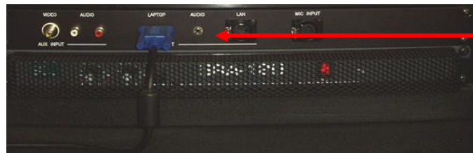
Laptop Cable Inputs
